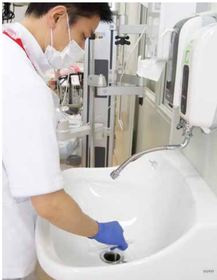
改修工事を終えた手洗い場での環境のモニタリング
