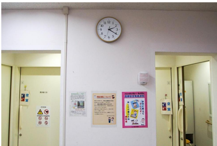
時計が無かった第 2MR 検査棟待合室に壁掛け時計を設置
